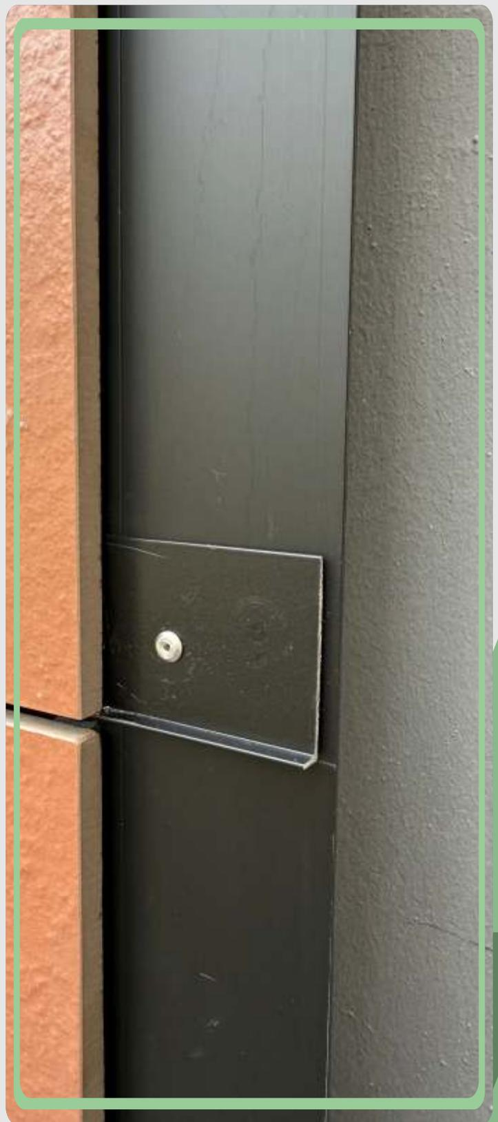
La superficie lisa ofrece condiciones ideales para la aplicación del polímero MS. Al ser regular y continua, permite que el adhesivo se esparza de forma homogénea, formando una capa cohesiva y sin fallos internos. Esto garantiza un espesor constante del cordón, esencial para el curado adecuado y el desempeño estructural de la junta. Además, facilita la limpieza de la base, eliminando polvo e impurezas. También refuerza el efecto de microventosas, contribuyendo a una adhesión más eficiente.
