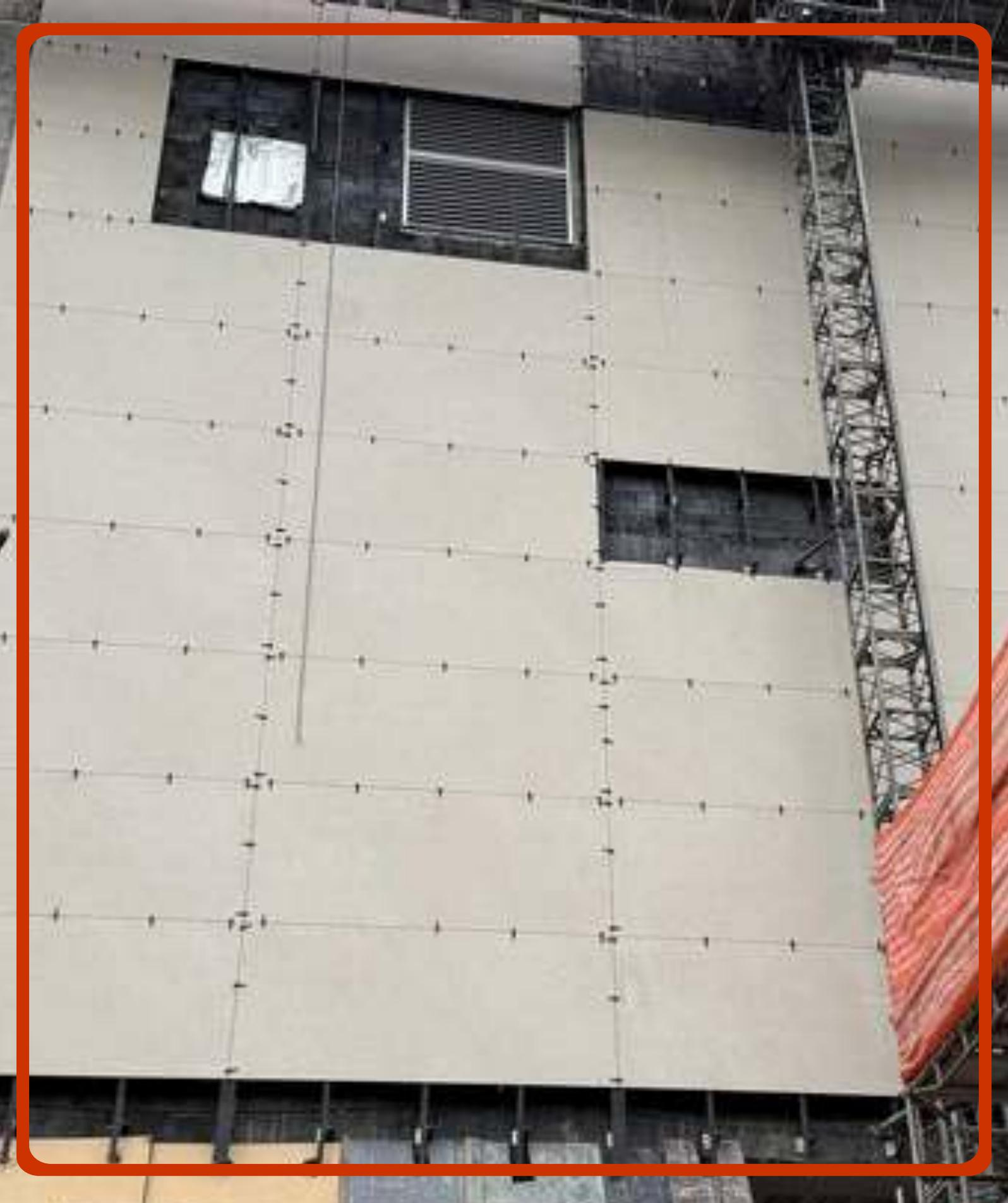
La aplicación de un revestimiento en formato 1200×2800×6 mm, con alta rigidez y resistencia a la curvatura, directamente sobre la perfilería, constituye una solución técnicamente crítica. Por tratarse de una pieza de gran tamaño, con baja tolerancia a deformaciones, su instalación exige soporte continuo y mecanismos de alivio de tensiones. La ausencia de estos criterios puede comprometer el desempeño del sistema y aumentar el riesgo de fallos por ruptura o desprendimiento con el tiempo.
